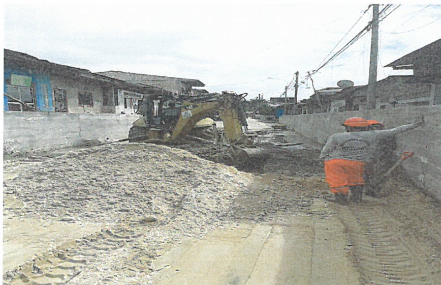
Limpieza de terreno
