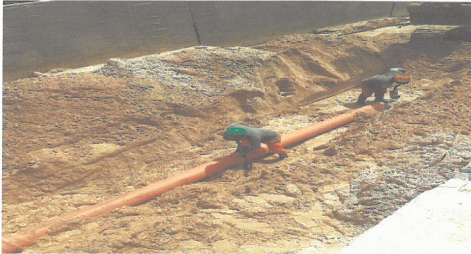
Instalación de Tuberías Jr. Itaya
