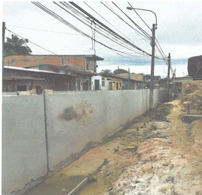
Muro de contención calle unión
