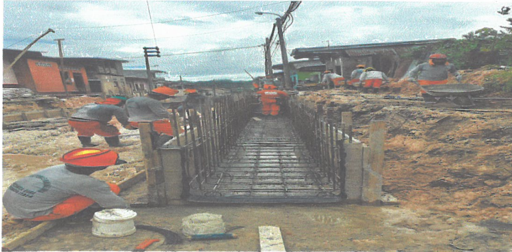
canal De Evacuación pluvial Jr. itaya
