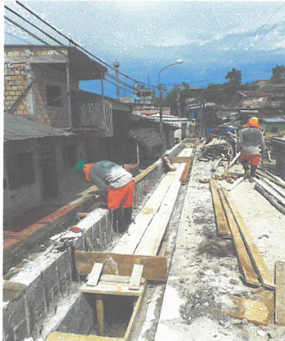
DERRAMES Y ENCOFRADO DE LOSA SUPERIOR CALLE HUASCAR
