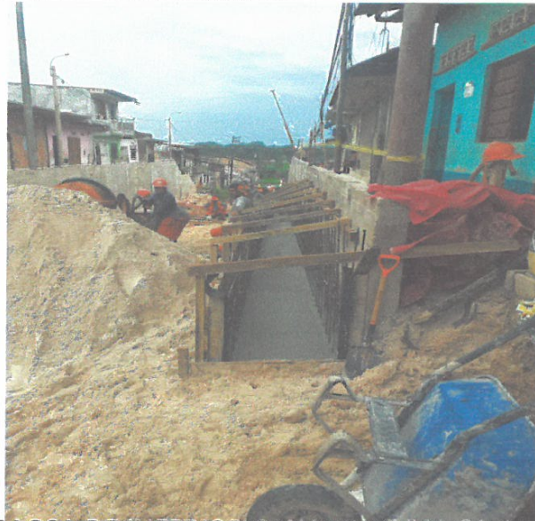
VACEO DE LOSA DE INFERIOR CANAL PLUVIAL CALLE UNION
