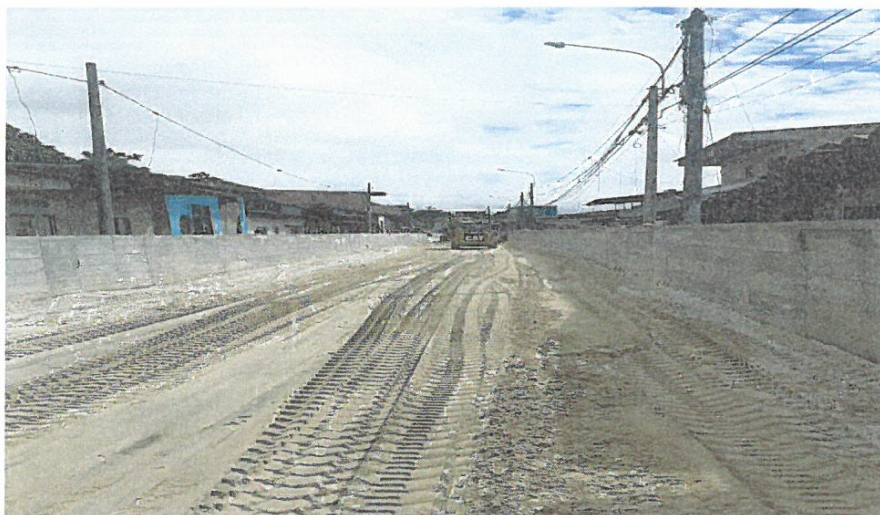
Relleno de sub rasante
