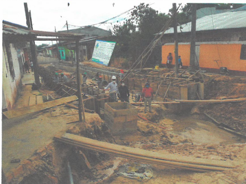
Verificacion de trabajos de canales pluviales Av. Participación/Jr. itaya
