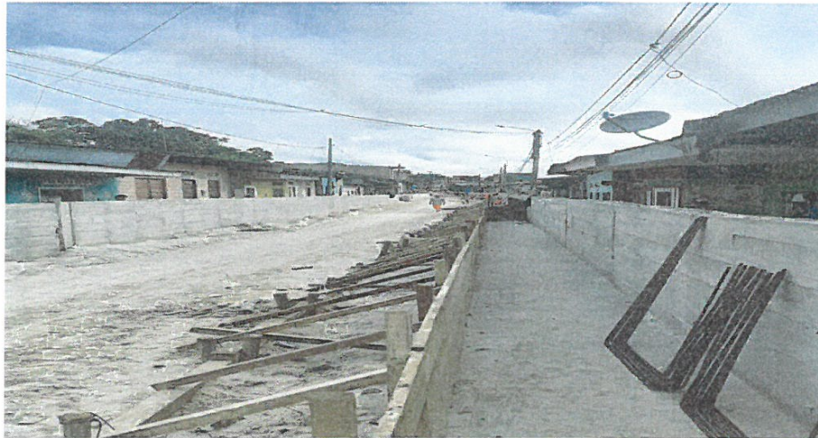
Encofrado de canal
