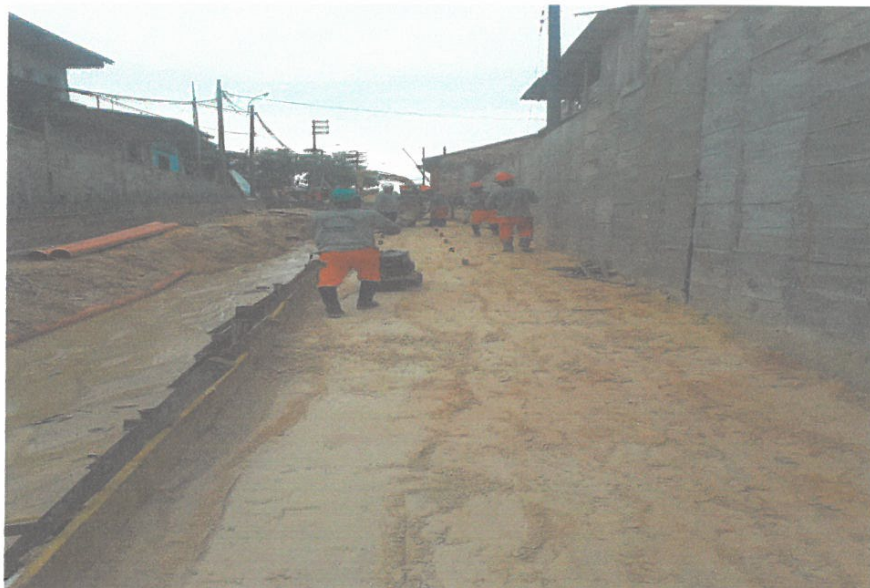
PREPARACION DE SOLADOS DE CANAL PLUVIAL JR ITAYA
