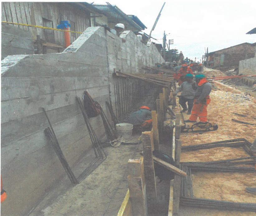
Armadura de canal Pluvial
