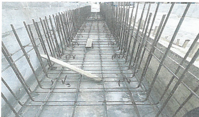
Armadura de canal
