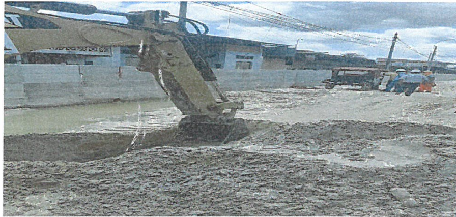
Limpieza de terreno
