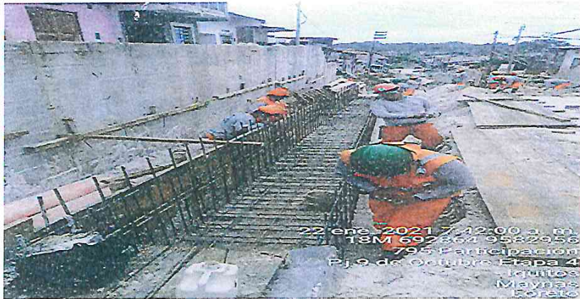
Armadura de canal de la calle itaya
