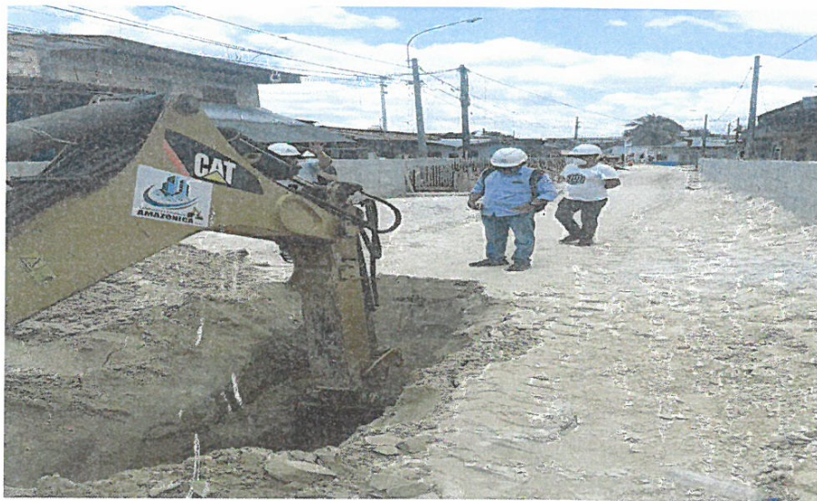
Supervisión de corte de relleno
