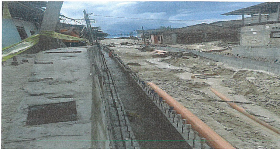
Estructura de canal
