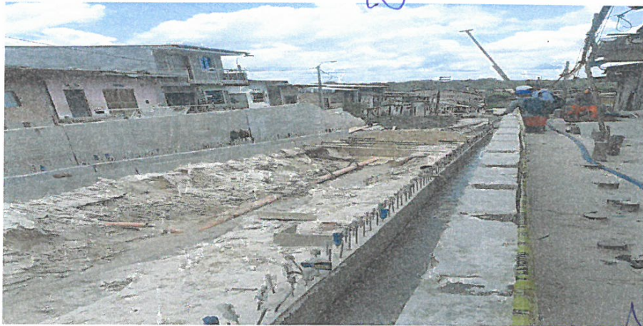
Instalación de tubos de matriz 250mm
