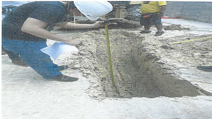
Verificación del corte de relleno
