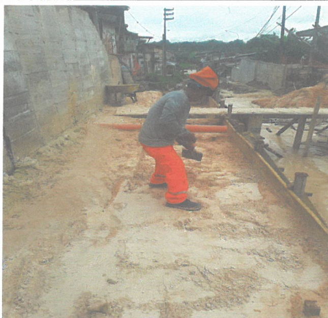
RELLENOS CON MATERIAL GRANULAR CALLE ITAYA
