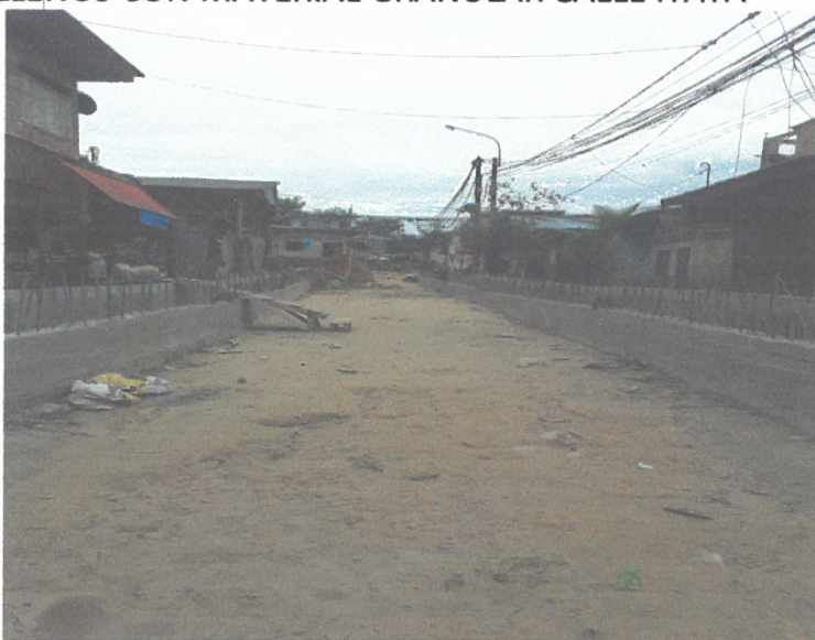
RELLENOS CON MATERIAL GRANULAR CALLE ITAYA
